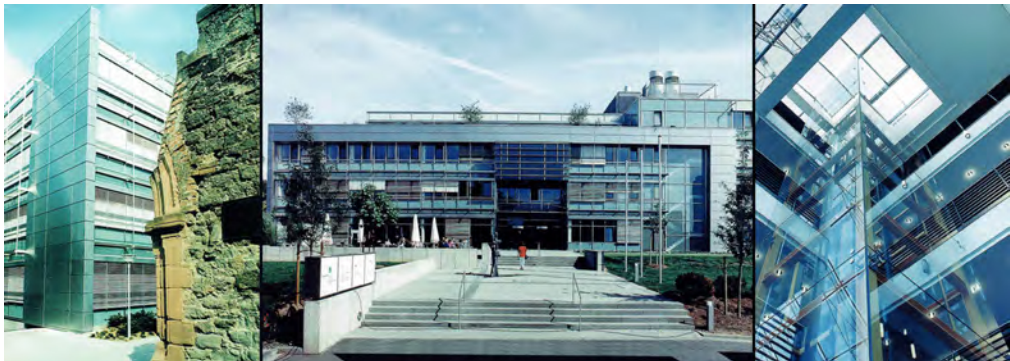
Abbildung 31: Der Fraunhofer-IGD Instituts-Neubau in Darmstadt in der Rundeturmstraße wurde 1997 fertig.
